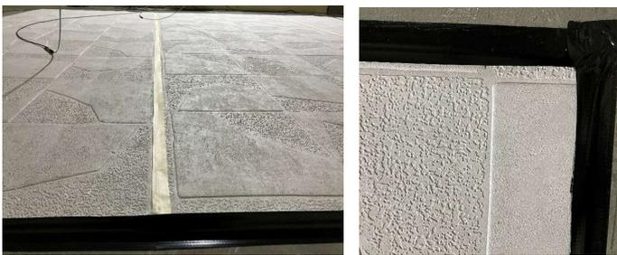
photo: détail des joints entre les multiples bandes du revêtements mural et les bords latéraux, recouverts d'une bande ruban adhésif non absorbant
