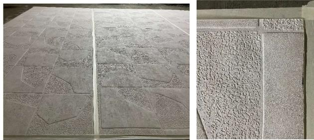
photo: détail des joints entre les multiples bandes du revêtements mural et les bords latéraux, recouverts d'une bande ruban adhésif non absorbant
